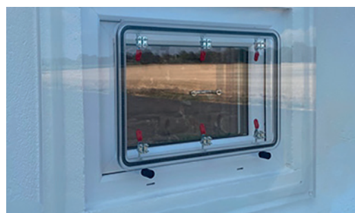
steinau Wasserschutz - Fenster Außenansicht
